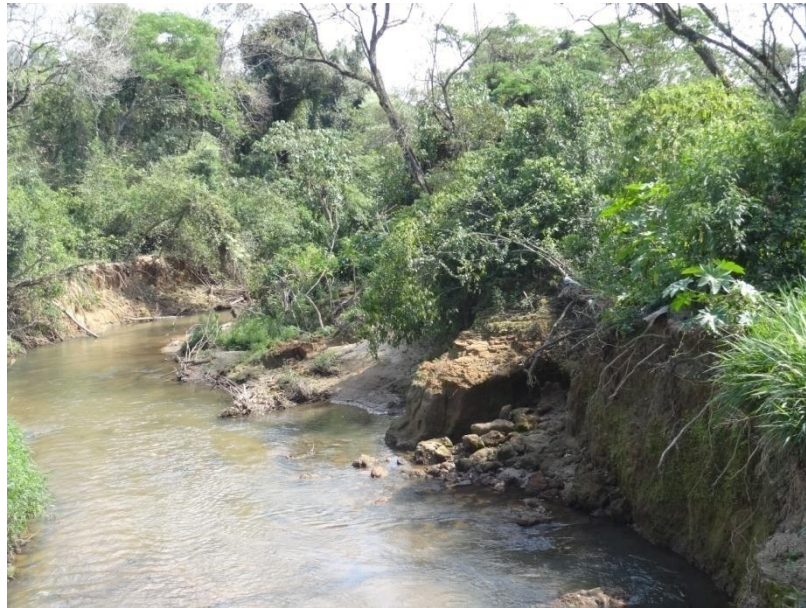
Figura 57. Evidência de erosão em corpo d'água, Área Norte do município de Mairinque, SP. Coordenadas Geográficas UTM: 23S 262780 7404736.
